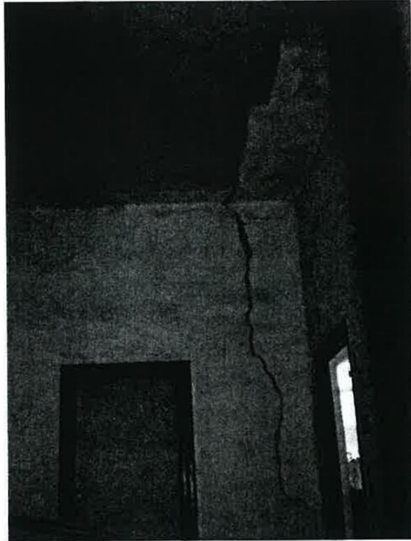
Fotografía nº 3: Detalle de la grieta nº 1 por el interior que parte el edificio por la mitad tanto los forjados como los tabiques.
