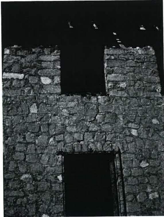
Fotografía nº 5: Detalle de la grieta nº 2 desde el exterior. Esta grieta parte por completo el ala izquierda del edificio.
