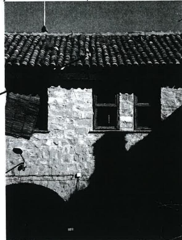
Fotografía nº 4: Detalle de la grieta nº 1 desde el patio interior y como parte el edificio por la mitad incluso la cubierta.
