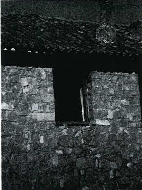
Fotografía nº 8: Fotografía de la grieta nº 3 desde el patio interior y como parte por completo el edificio incluso la cubierta.
