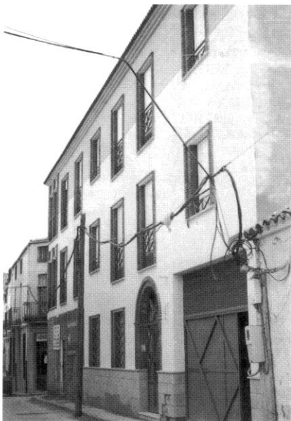
FOTOGRAFÍA FACHADA C/. CACHORRO
