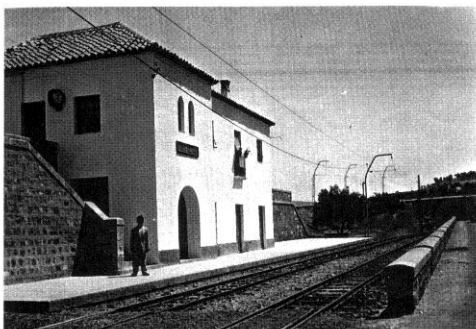
Foto 3. Estación de Tres Olivas.
