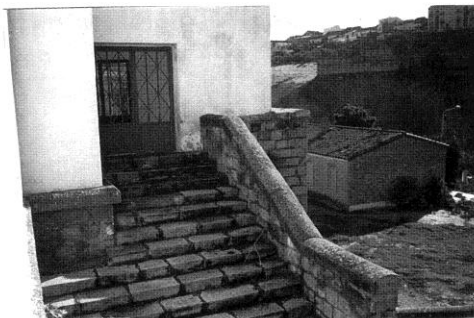
Foto 2. Estación de Tres Olivas.
