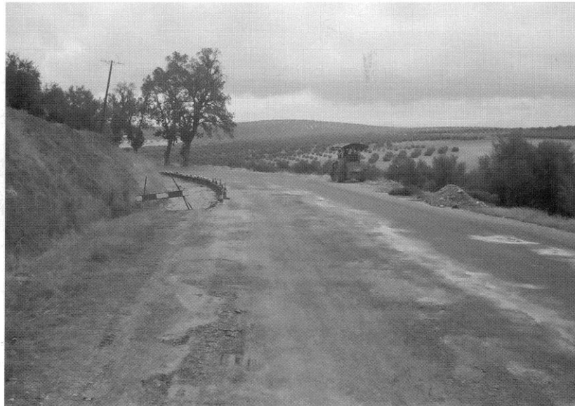
Acondicionando la carretera
